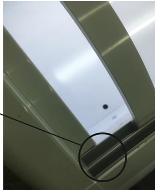
**⚠ ¡ATENCIÓN!** El marco de plástico en el que se encajan las tapas tiene un lubricante especial para garantizar un buen deslizamiento. Con el tiempo puede que tenga que lubricar el marco. En caso de que sea necesario póngase en contacto con el servicio posventa.
